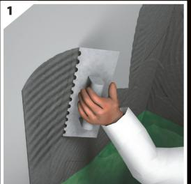
Breng flexlijm\* aan op een zuivere ondergrond met een lijmcam (vertanding 3x3 mm)
