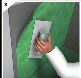
Druk de Greenloxmat aan met de vlakke zijde van de lijmcam. Vermijd luchtbellen.
